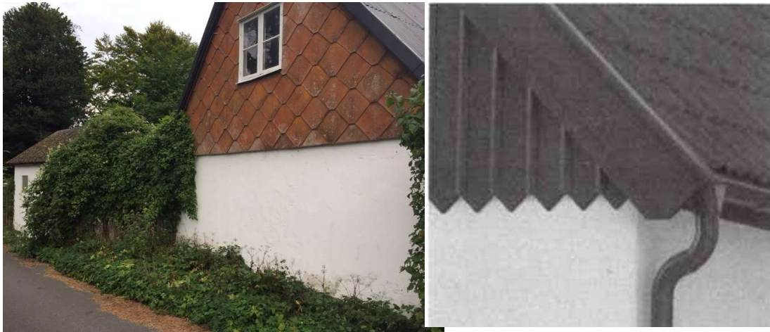
Takfoten är nätt utformad med ett utstick från fasaden på maximalt 200 mm. Gavelspetsar i olika utförande.
